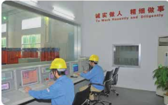
变压器检测中心 Transformer Inspection and Test Center
