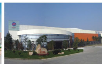
上海基地 Shanghai Facility
